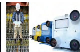
リアルタイム自動配筋検査システム
