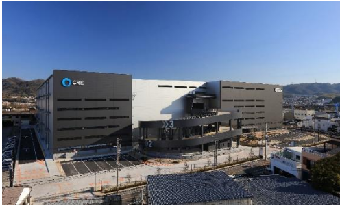
19 ロジスクエア大阪交野 2021年1月竣工
