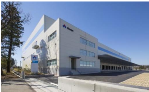
3 ロジスクエア日高 2015年3月竣工
