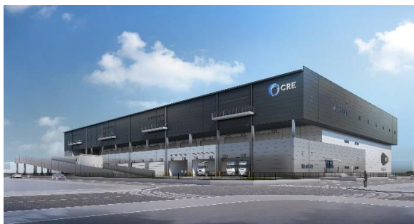
22 ロジスクエア白井 2022年12月竣工予定
