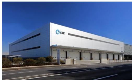
6 ロジスクエア久喜Ⅱ 2017年2月竣工
