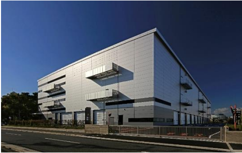
21 ロジスクエア伊丹 2022年11月竣工
