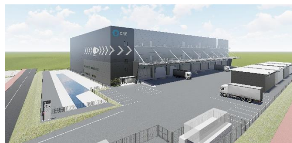
27 ロジスクエア福岡小郡 2024年2月竣工予定
