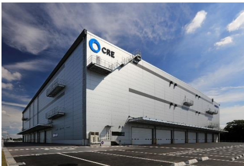
13 ロジスクエア春日部 2018年6月竣工
