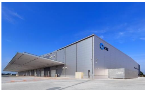
5 ロジスクエア羽生 2016年7月竣工
