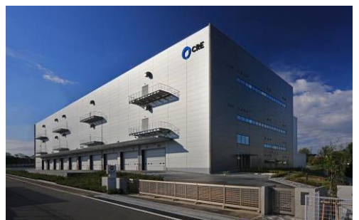
8 ロジスクエア新座 2017年4月竣工
