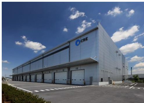
15 ロジスクエア川越Ⅱ 2019年6月竣工
