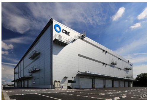
13 ロジスクエア春日部 2018年6月竣工
