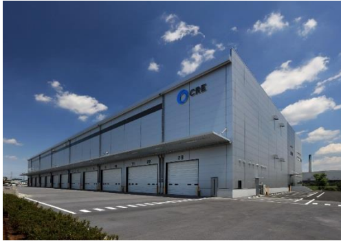
15 ロジスクエア川越Ⅱ 2019年6月竣工
