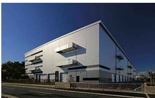
21 ロジスクエア伊丹 2022年11月竣工
