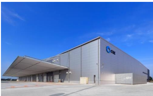
5 ロジスクエア羽生 2016 年 7 月竣工
