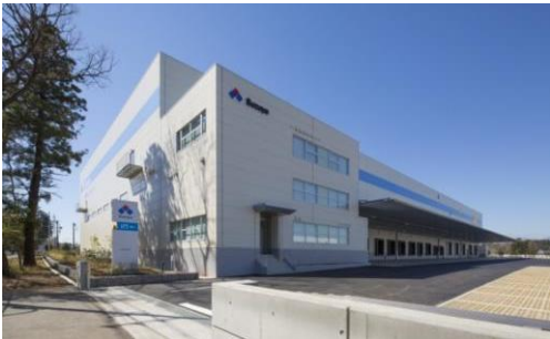
3 ロジスクエア日高 2015 年 3 月竣工
