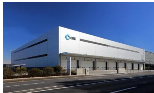
6 ロジスクエア久喜Ⅱ 2017 年 2 月竣工
