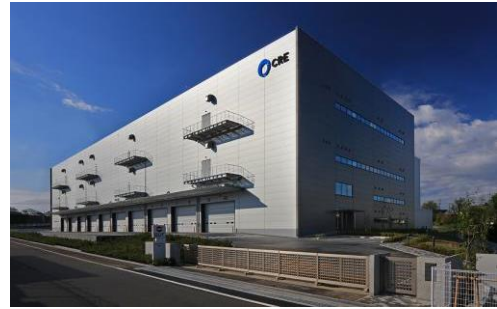
8 ロジスクエア新座 2017年4月竣工
