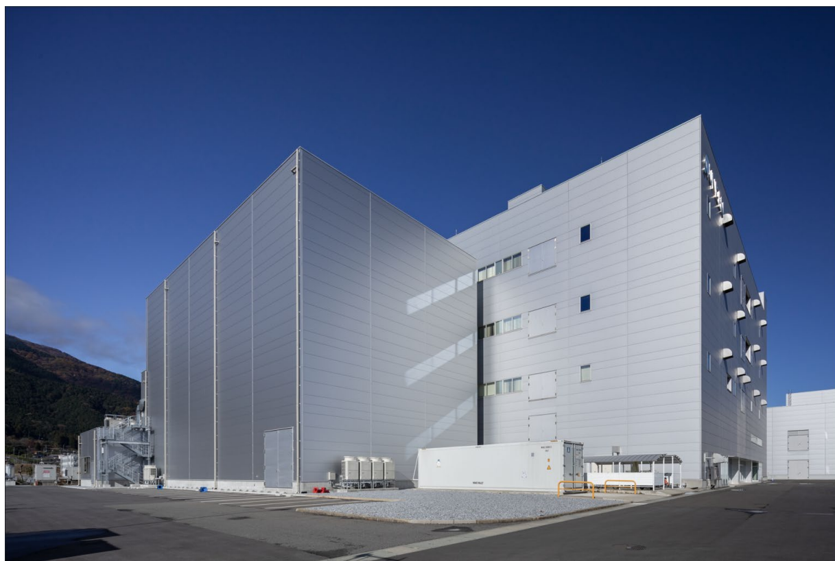
ワクチン原薬製造設備外観
