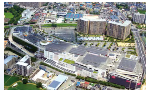
屋上・壁面の太陽光パネルなど環境に配慮した設備
