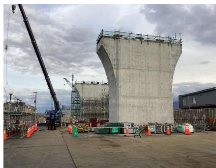
山梨県内 白井河原高架橋 橋脚工
