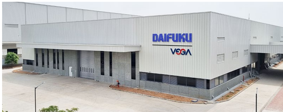
現在稼働中の工場
