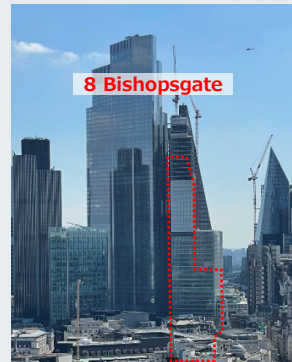
▲ Exterior phot (Jul. 2022)
