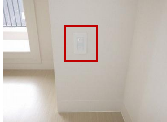
右) 居室内壁埋込み型 Wi-Fi
