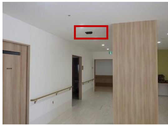
右) 廊下遠景 (天井設置)
