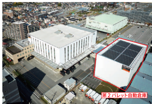
プラネット東関東 第2パレット自動倉庫
