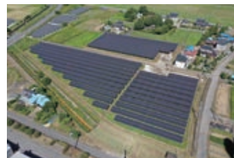
太陽光発電設備(埼玉県加須市)
