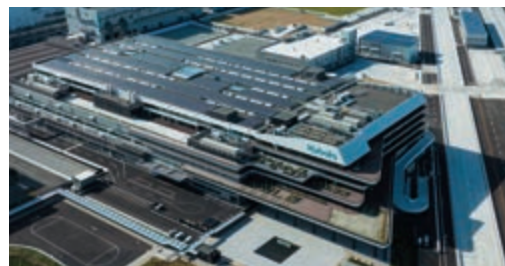
グローバル技術研究所に出力1566kWのソーラーパネルを設置（大阪）
