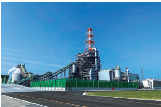
バイオマス発電プラント
