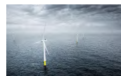
Luchterduinen offshore wind farm
