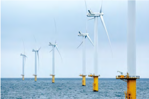
Luchterduinen Offshore Wind Farm
