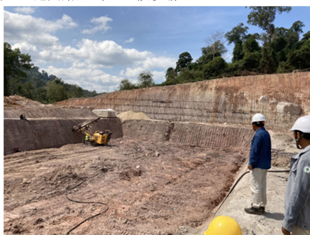
ダム本体工事中に水を迂回させるための迂回路トンネル建設現場
