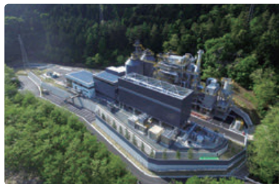
バイオマス発電プラント
