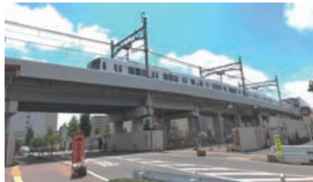
高架化した新鎌ヶ谷駅付近
