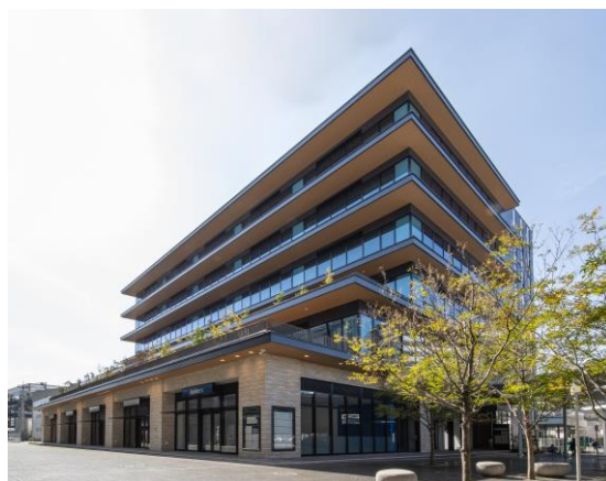
熊本 Lab.が入居する JR 熊本春日北ビル外観
