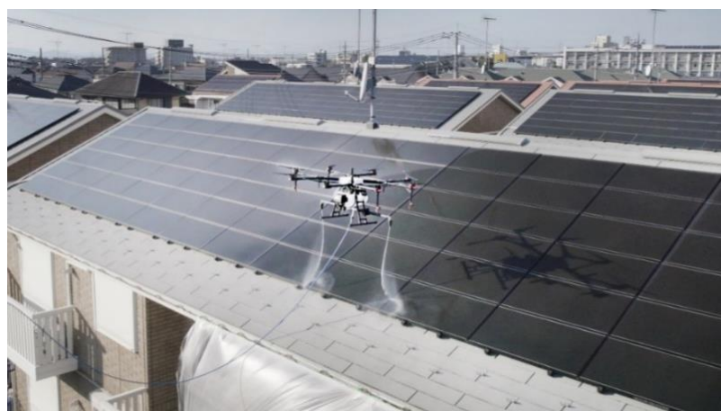
屋根部の洗浄の様子
