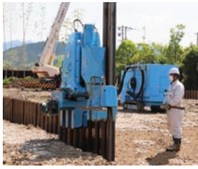
①鋼矢板圧入
