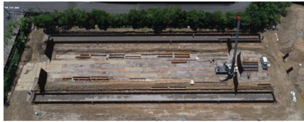
②圧入完了後
