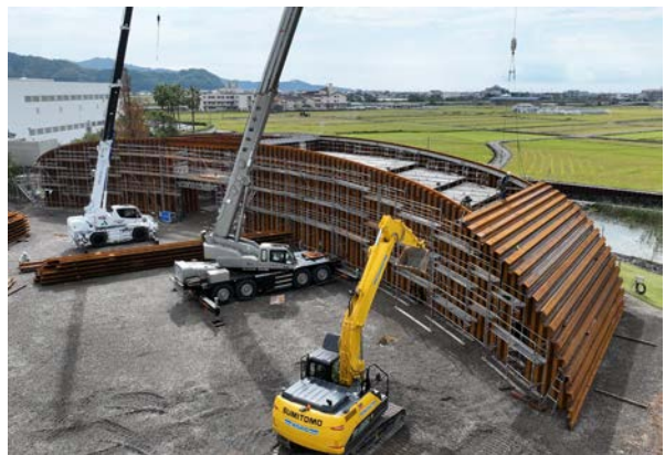
④屋根を設置
