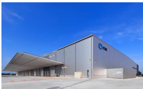
5 ロジスクエア羽生 2016年7月竣工
