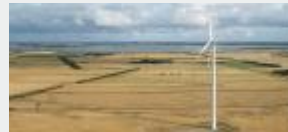
トービー・リニューアブルズ社所有の風力発電所 「Vognkær (ボウクアー)」
