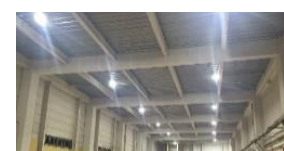
グリーンリース契約に基づくLED化改修
