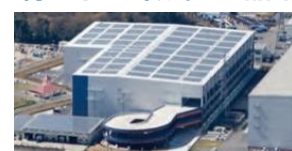
太陽光パネルの設置
