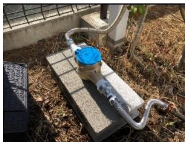
自動散水栓にサブメーターを設置し、より 詳細の水使用量を把握し、節水施策に つなげる
