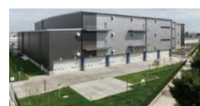
緑化駐車場の設置
