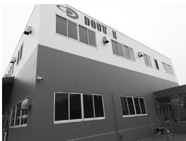
千葉県船橋市に新設した 【関東流通センター】
