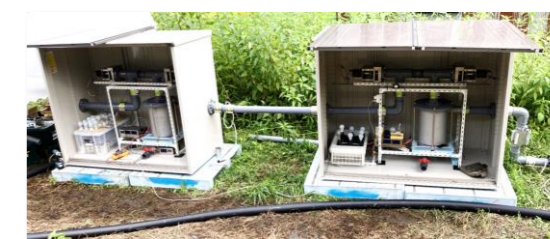
農業用水路での連結運転検証
