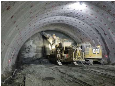
第一中京圏トンネル 大森工区 本坑の掘削
