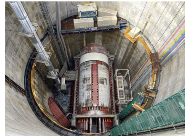
第一首都圏トンネル 梶ヶ谷工区 シールドマシンの状況
