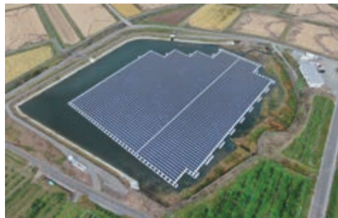
いちご上田吉田池E C O発電所
