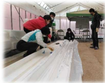
ベッドに、防水・給水・防根シートを張り、その上にバミスを敷き詰める
