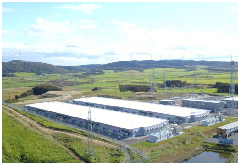
蓄電池システム外観
