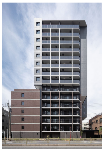
The Parkhabio Minamiooi
