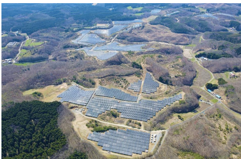
鮫川青生野（さめがわあおの）太陽光発電所
