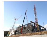
ごみ焼却炉プラント工事
