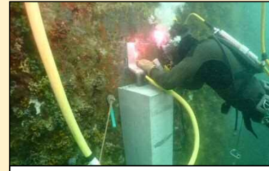
水中溶接作業の様子
