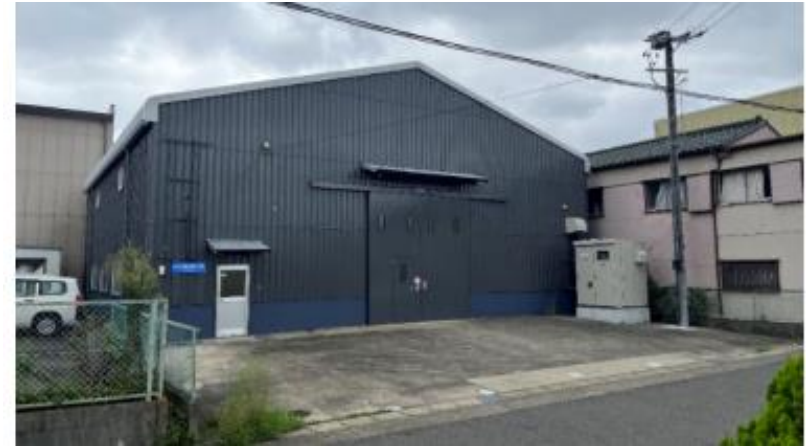
名古屋第二工場の新設
