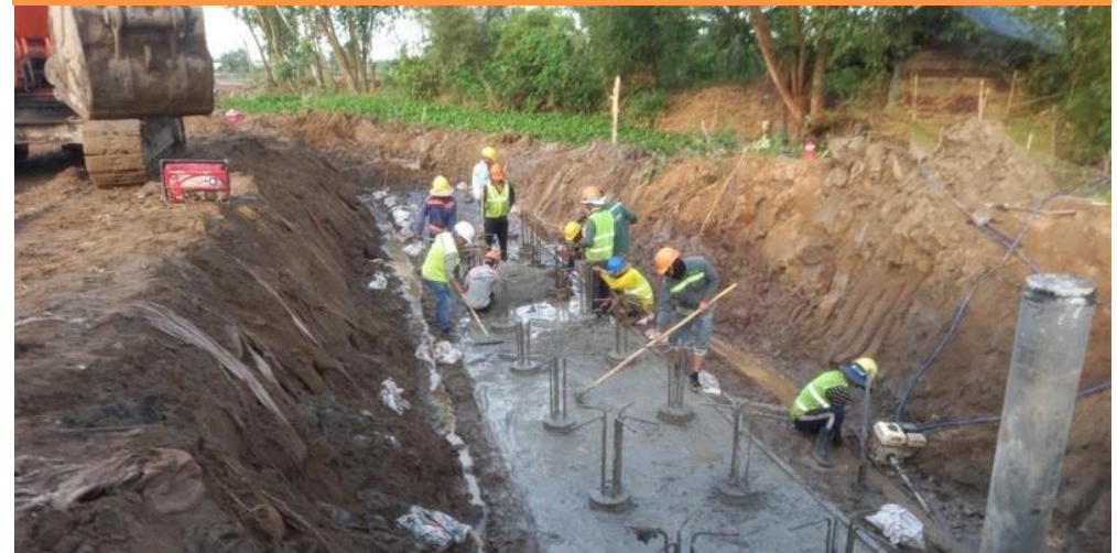
敷地境界の堰堤工事
