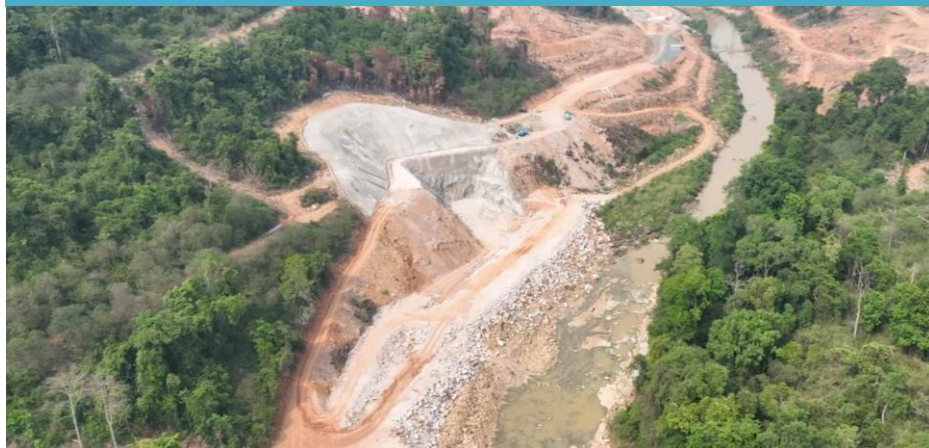
迂回トンネル出口掘削工事
