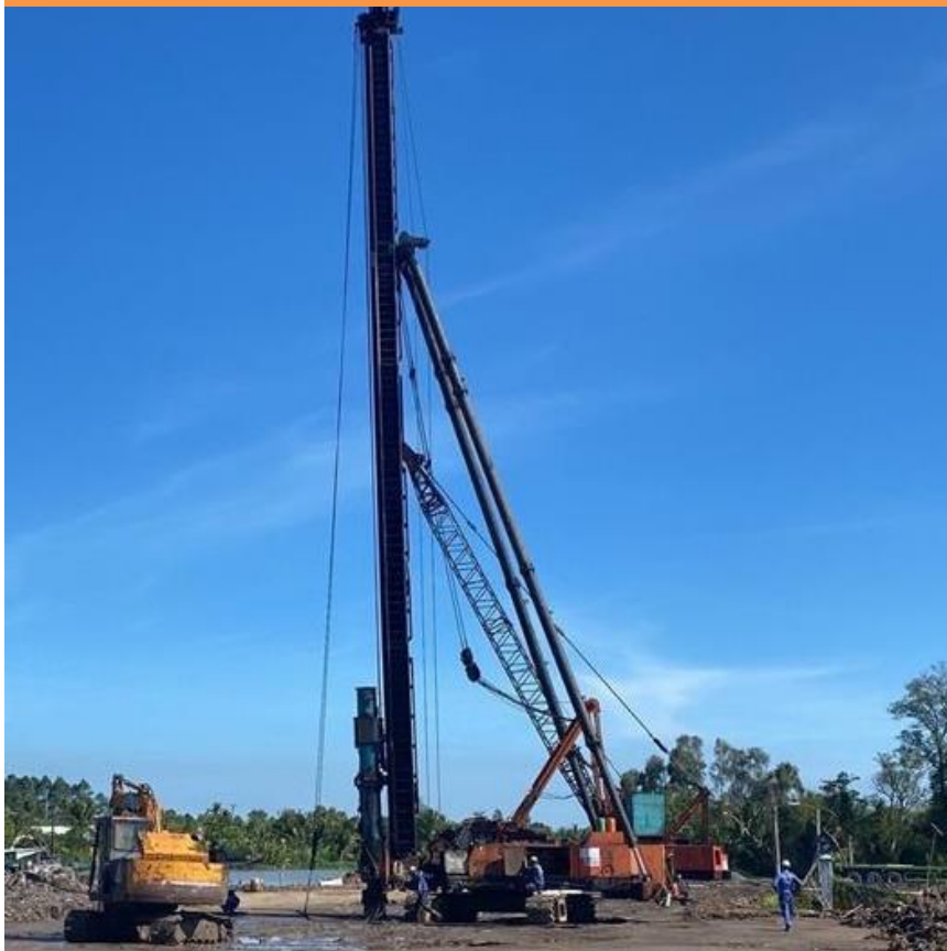
基礎工事(試験杭打ち)
