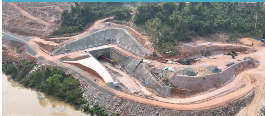
迂回トンネル出口掘削工事
