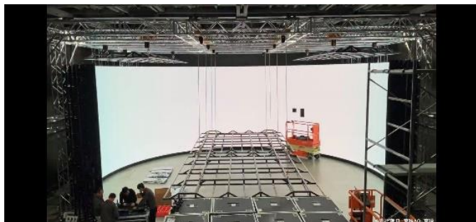
建設中のLEDウォール
