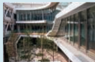
大規模改修を終えた筑波研究所
