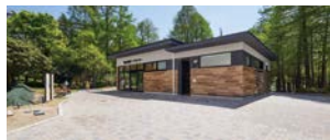
桃山公園(新設したパークセンター)
