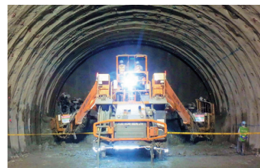
南アルプストンネル山梨工区 (本坑の掘削)
