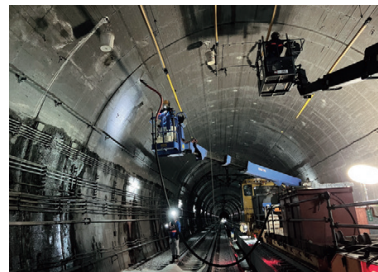
東海道新幹線大規模改修工事
