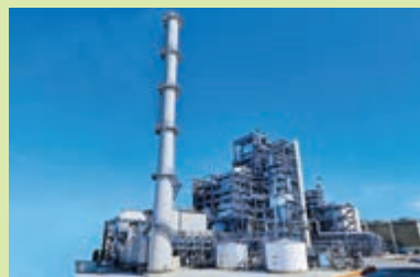
徳山バイオマス発電所
