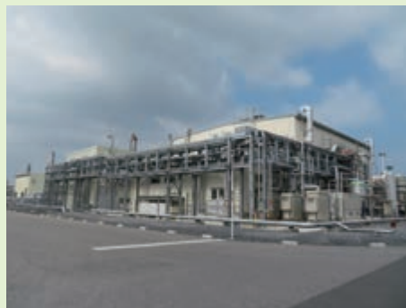
小型実証設備 第1プラント
