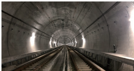
相鉄・東急直通線、羽沢トンネル他 (神奈川県横浜市) 発注者: 独立行政法人鉄道建設・運輸施設整備支援機構
