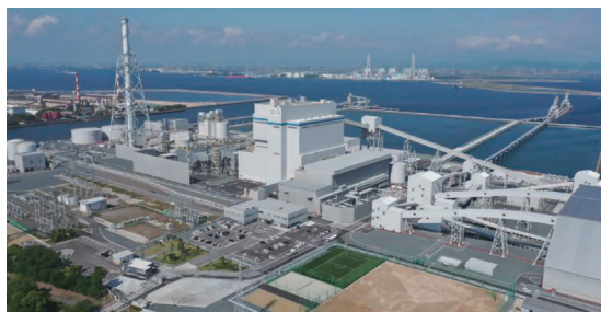
武豊火力発電所5号機 土木建築工事 (愛知県知多郡) 発注者: JERAパワー武豊合同会社
