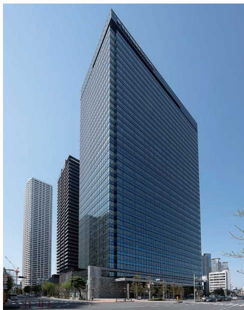
西新宿五丁目北地区防災街区整備事業に係る 施設建築物等新築工事 (東京都新宿区) 発注者: 西新宿五丁目北地区防災街区整備事業組合
