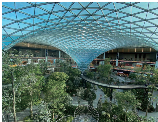
カタール ハマド国際空港旅客ターミナル拡張工事 (カタール国) 発注者: カタール空港運営管理会社 (MATAR)
