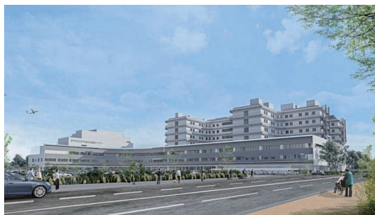
統合新病院整備工事 (兵庫県伊丹市) 発注者:市立伊丹病院・公立学校共済組合
