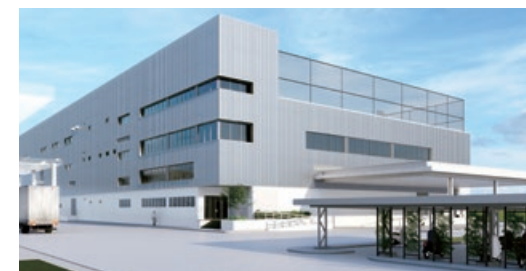
▲アズビルプロダクシオンタイランド新工場棟（2024年春竣工予定）
