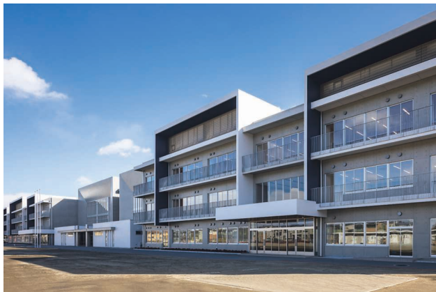
工事名：3-4国債（仮称）研究学園小学校・中学校建設工事 発注者：つくば市
