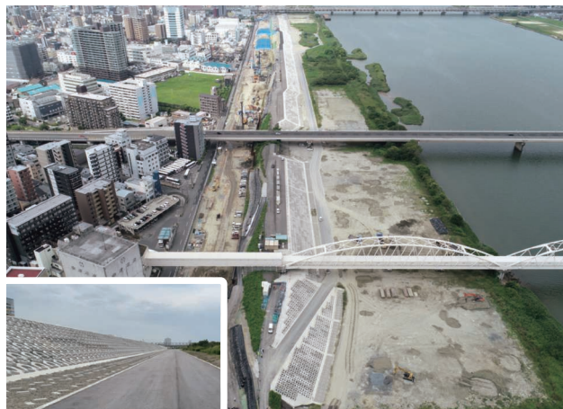
工事名：淀川左岸線（2期）2工区堤防整備他工事 発注者：国土交通省近畿地方整備局
