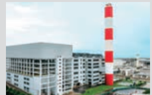
廃棄物焼却発電施設（シンガポール）
