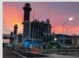
ガス複合火力発電所（タイ）
