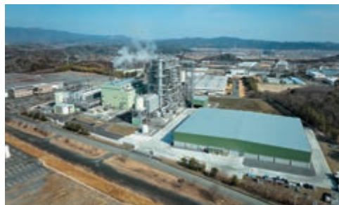
福島いわきバイオマス発電所
