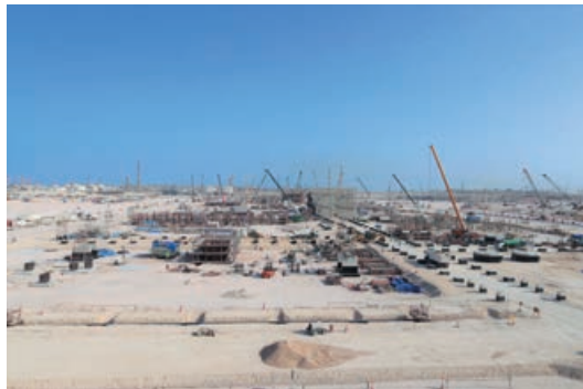
カタールNFE LNG建設現場 Courtesy of QatarEnergy
