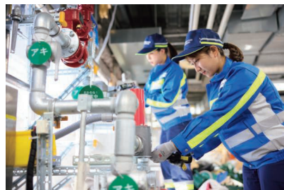
供給設備の安全点検の様子
