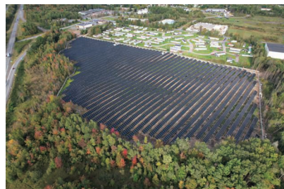
Summit Ridge Energy, LLCが開発した 太陽光発電所 (米国メイン州)
