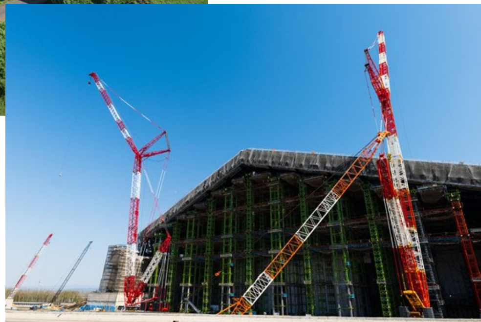
北海道ボールパーク鉄骨 株式会社大林組他JV
