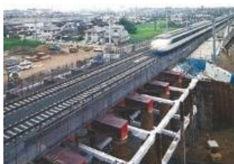
東海道新幹線箕輪架道橋
