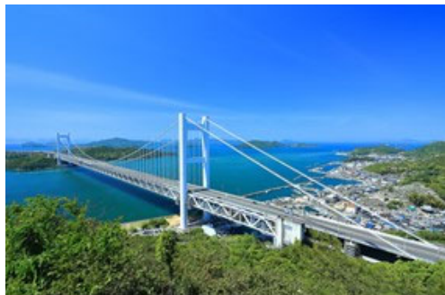
下津井瀬戸大橋
