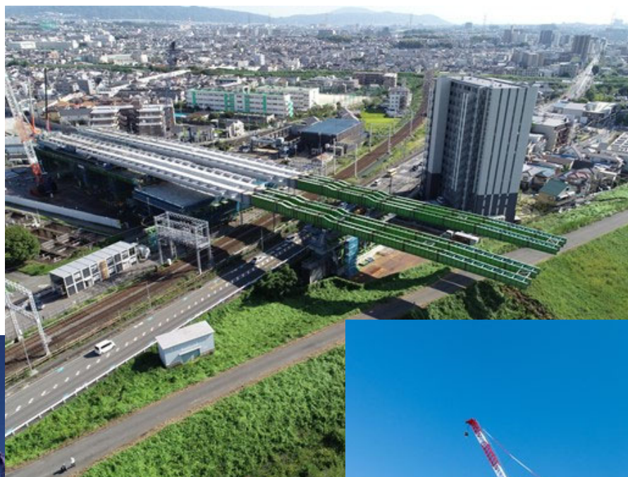
京阪電鉄 淀川東高架橋工事 鹿島建設株式会社
