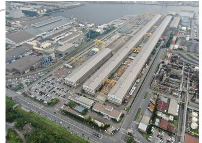
宮地エンジニアリング(株) 千葉工場
