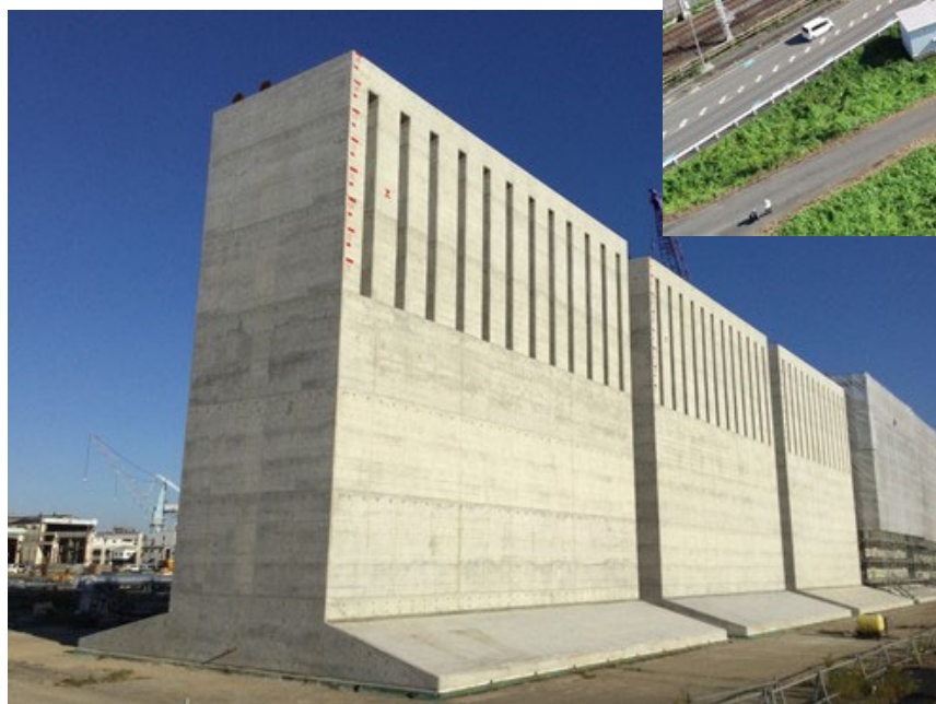
新本牧地区護岸(防波)本体工事 国土交通省関東地方整備局
