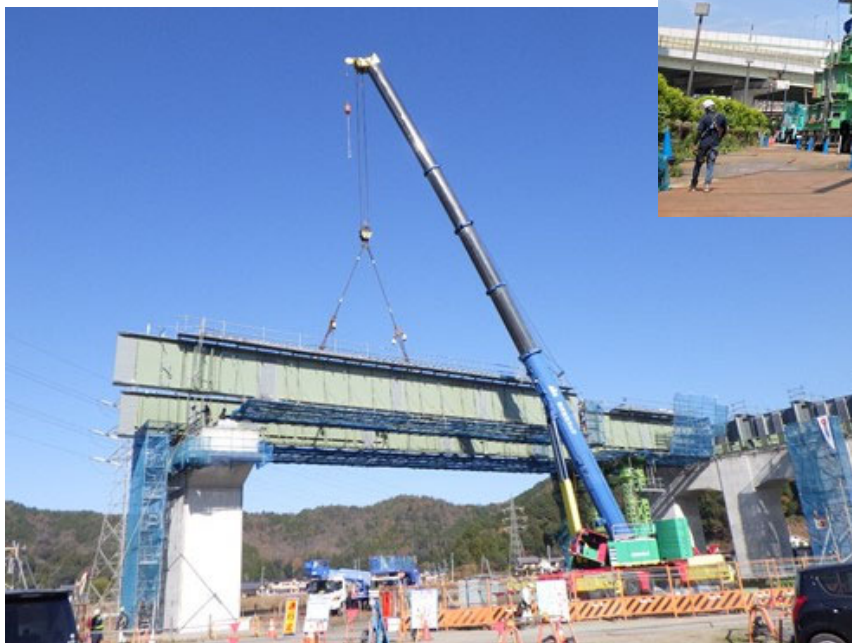
東海環状西深瀬高架橋西鋼上部工事 国土交通省中部地方整備局
