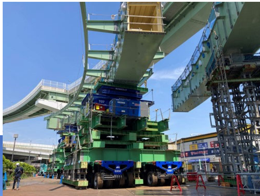
海老江工区鋼桁および鋼製橋脚工事 阪神高速道路株式会社
