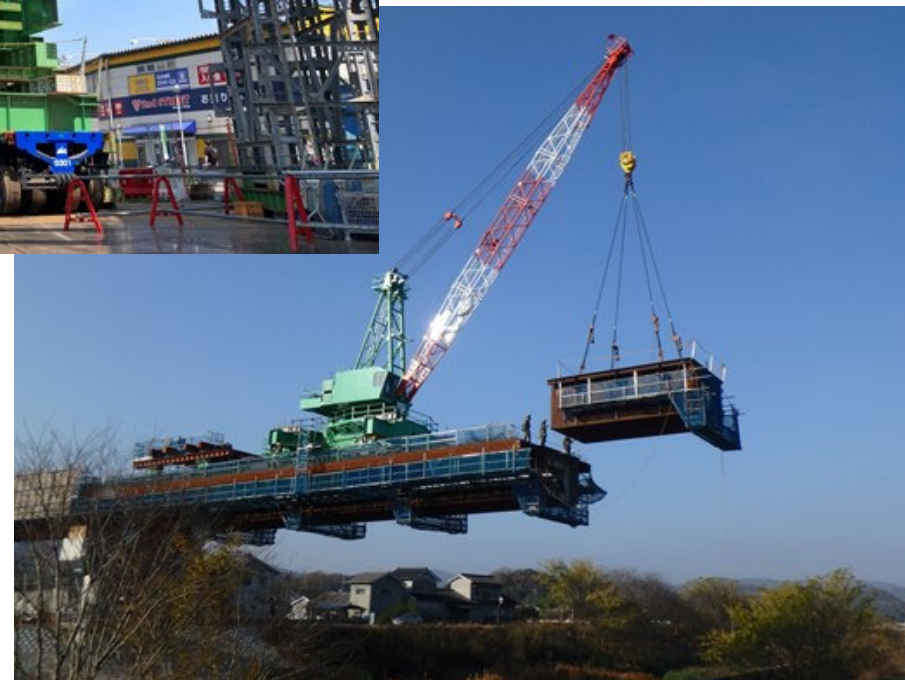
津之郷山守線(福山西環状線) 道路改良工事(R2-2工区) 広島県
