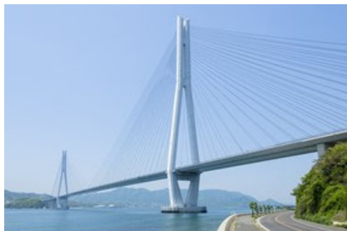
多々羅大橋
