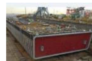
東京港海の森トンネル沈埋函
