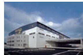
東海ロジスティクスセンター
