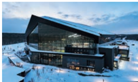
開閉式の大屋根は、積もった雪を屋根から落雪させない設計となっている
