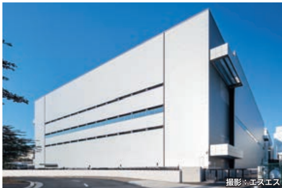
キャノン株式会社平塚事業所 H棟建設工事（神奈川県）
