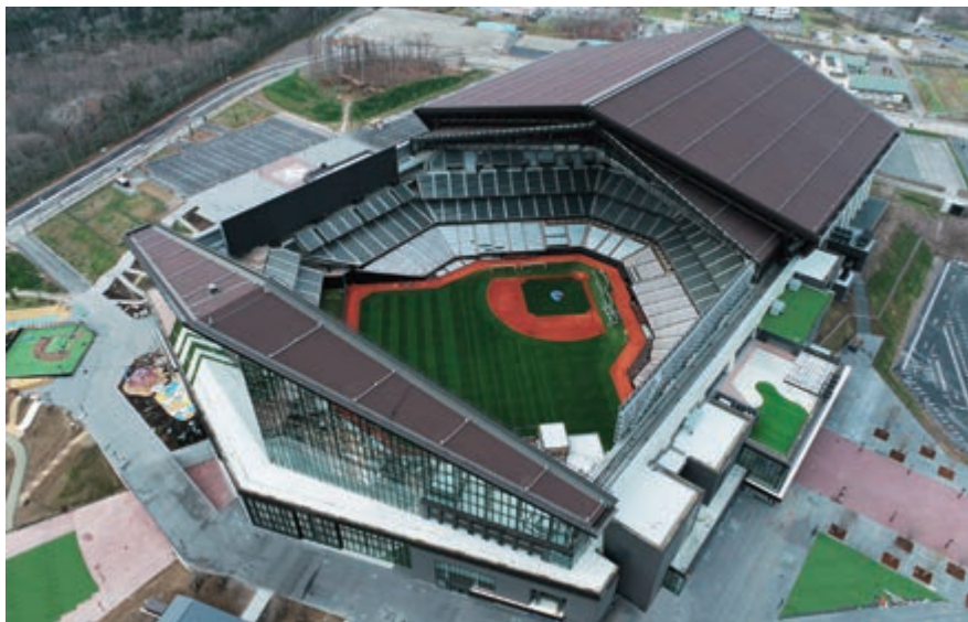
ES CON FIELD HOKKAIDO建設工事（北海道）
