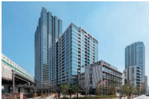
白金ザ・スカイ新築工事（東京都）
